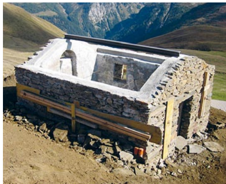
Die Kapelle «Maria zum Schnee» auf der Alp «Furgge» wird renoviert.
